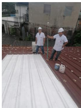
APLICAR UN RECUBRIMIENTO SEGUN LA NECESIDAD IMPER5, PINTURA
