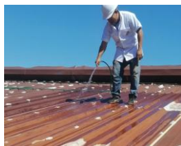
LIMPIAR Y PREPARAR LA SUPERFICIE
